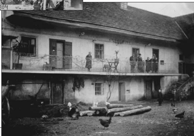
Mlín a dvůr v roce 1904. Dveře a okno v pravé části byly zrušeny při přestavbě západní části objektu mlýna na RD čp. 888 v letech 1990 až 1993, okna a dveře v levé části byly vyměněny při současné přestavbě, ale otvory byly zachovány ve stejných místech.
