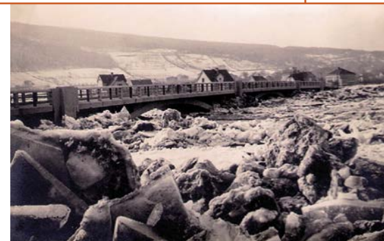
Most v Letech za povodně v r. 1941.
